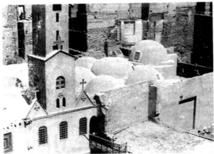
واجهة كنيسة السيدة العذراء المغيثة وسطها بحارة الروم وتُرى بقايا مبان تابعة للكنيسة قبل عمليات الترميم سنة ١٩٨٢
