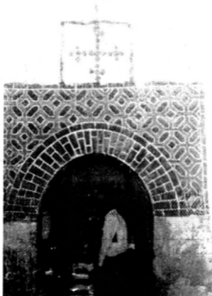
باب هيكل القديس يحنس القصير - شرق ملوى (تاكل الخشب واستبدل به طوب أحمر وأسود) (لوحة رقم ١٣٩)
